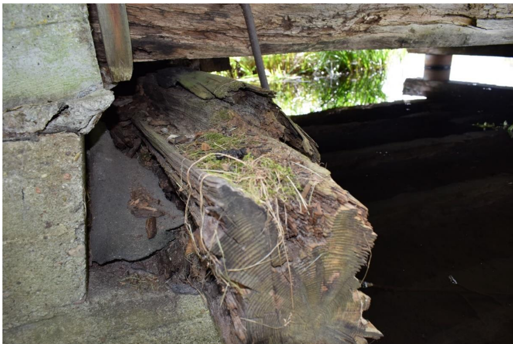
Zdegradowana belka podwalinowa na przyczółku po stronie jazu.
