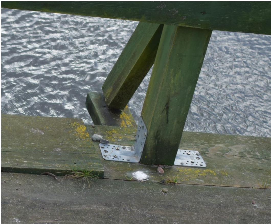
Uszkodzenie połączenia zastrzału z belką poprzeczną.
