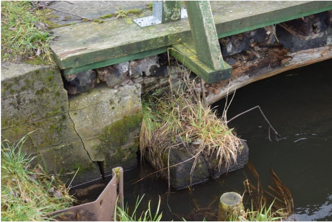
Pęknięcie korpusu przyczółka na styku z ścianą żwirową. Zalanie ławy podłożyskowej.
