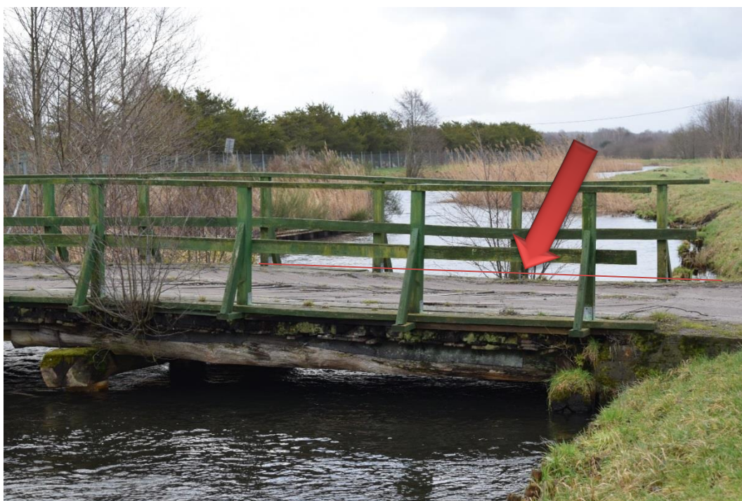
Ugięcie konstrukcji w miejscu uszkodzenia belki głównej.
