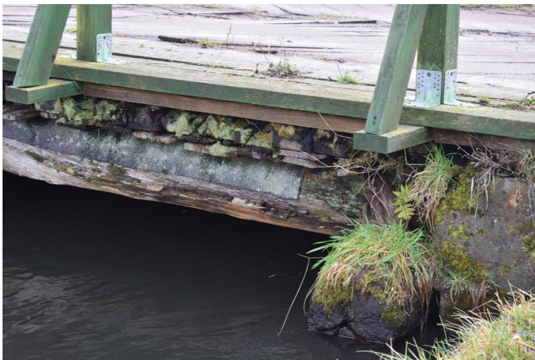
Stan techniczny dyliny i belki głównej po stronie północnej mostu.
