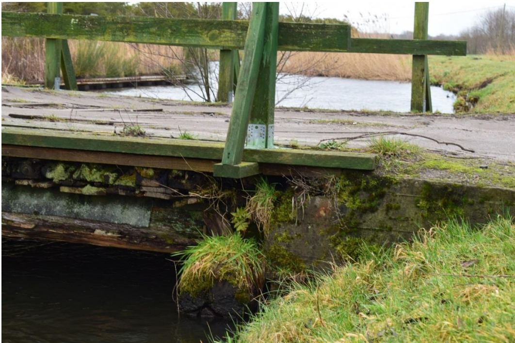
Zawilgocenie, wegetacja roślinności na ścianie przyczółka od strony północnej mostu. Zalanie ławy podłożyskowej.
