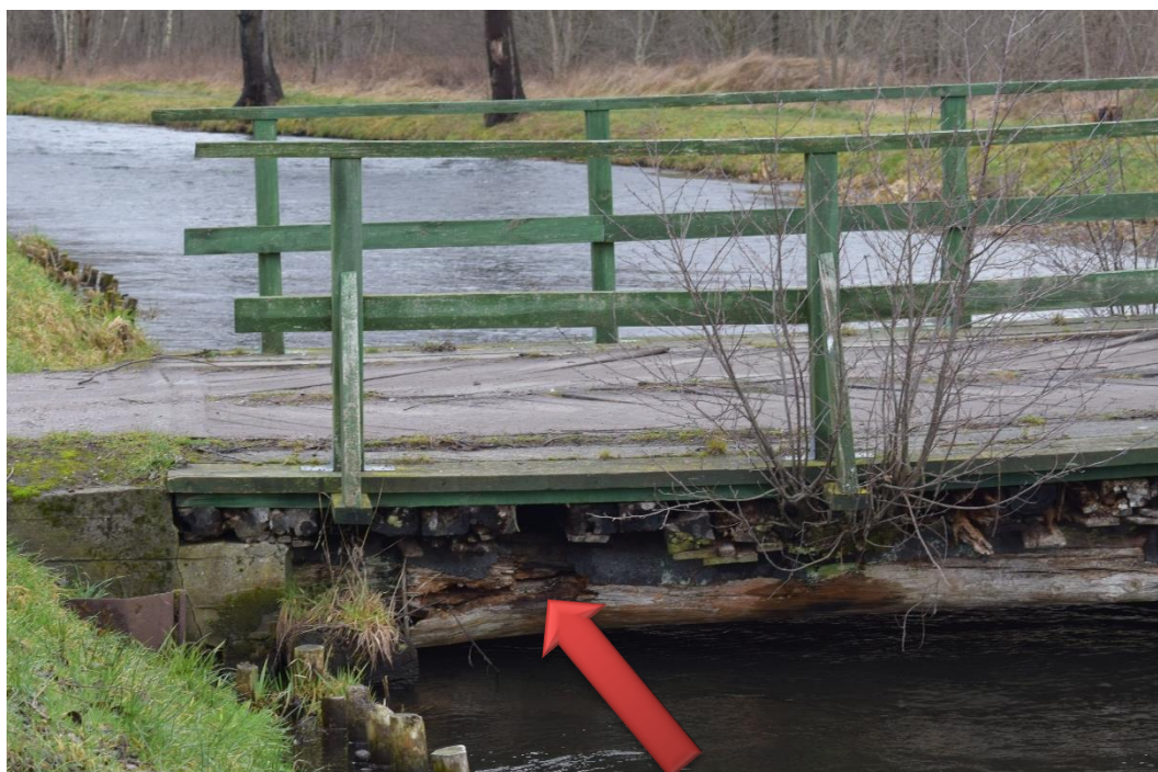
Uszkodzona belka główna mostu.
