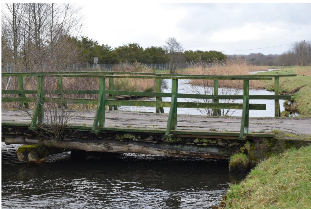
Położenie belek głównych względem poziomu wody przy normalnym stanie wody.
