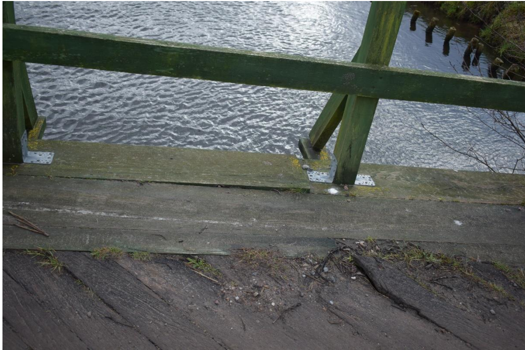
Uszkodzenie nawierzchni chodnika.
