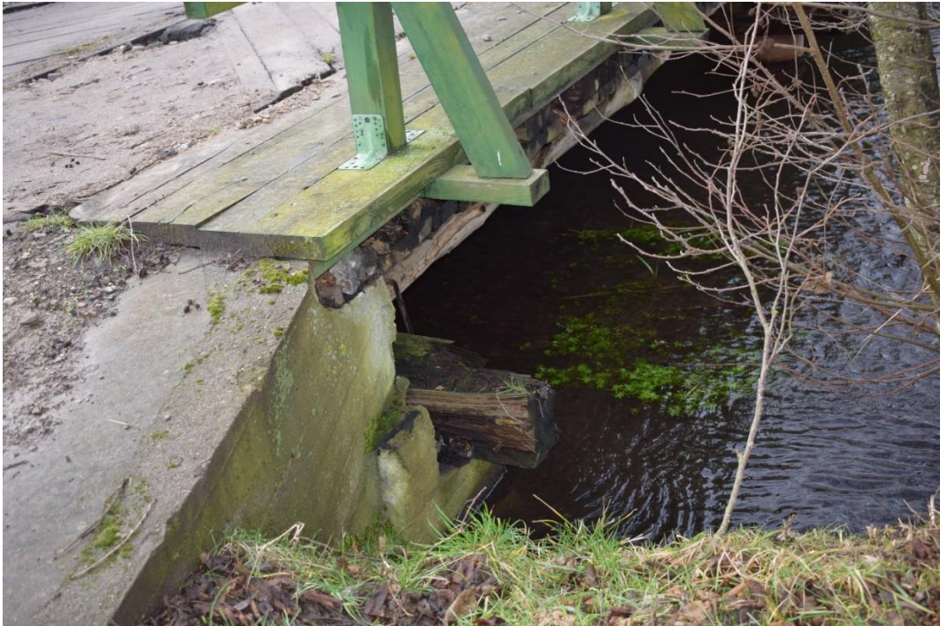
Ubytki betonu przyczółka po stronie jazu. Zawilgocenie betonu, wegetacja roślinności.
