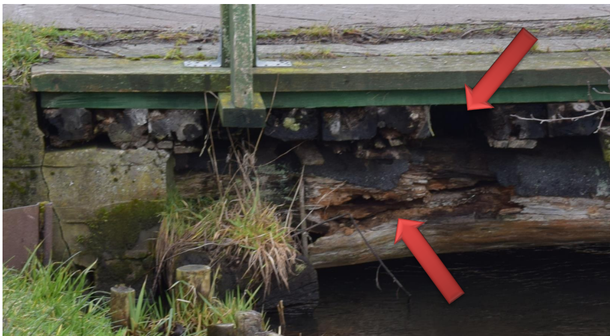
Zbliżenie obrazujące stopień uszkodzenia belki głównej.
